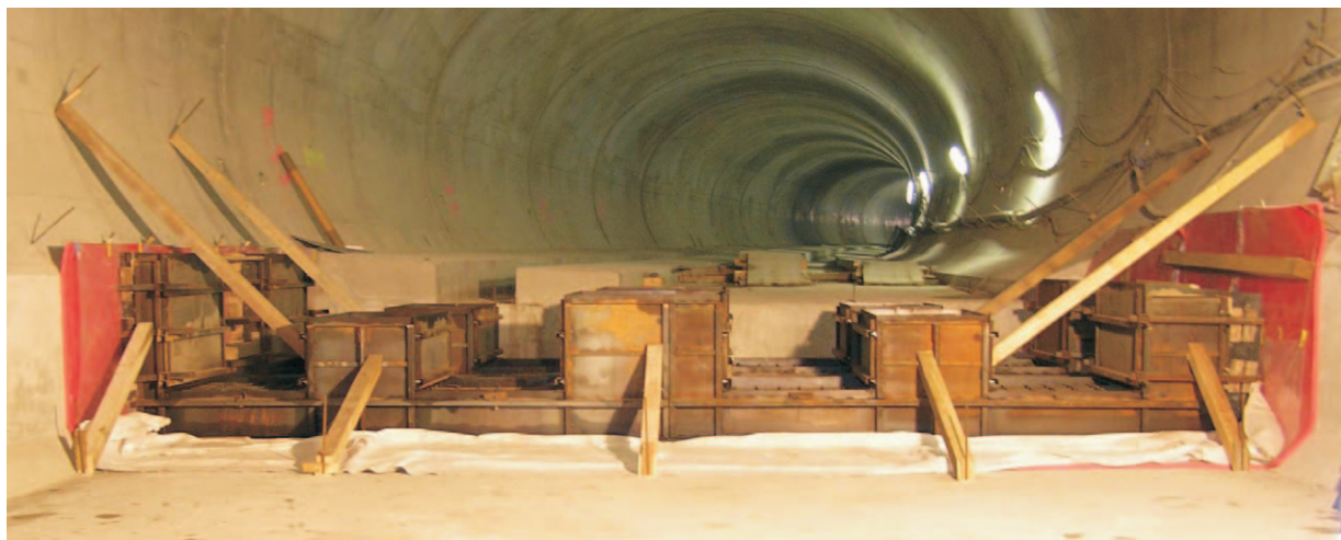
Obrázek 2: Fotografie pořízena během výstavby tunelu
