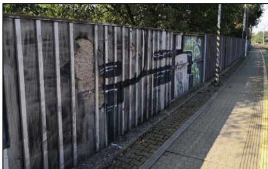
Obrázek 1. PHS jednostranně pohltivá z recyklovaného plastu – zastávka Dolany (foceno 2. 10. 2020) [zdroj: ČVUT]
