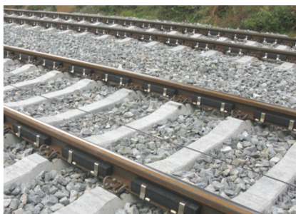
Obrázek 2. Příklad instalace mezipražcového kolejnicového absorberu (vlevo), příklad průběžného kolejnicového absorberu (vpravo)
